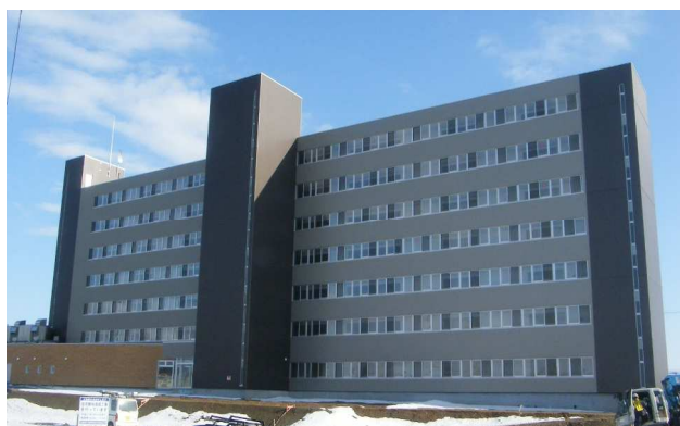
大曲駅前第二地区 都市再生住宅
